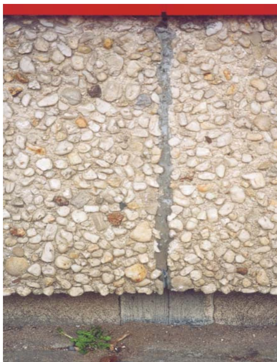
Abb. 4 Außenfuge Fassade
