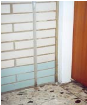
Abb. 13 Dehnungsfuge Wand
