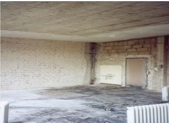
Abb. 16 Sanierungsbereich nach Totalausbau
