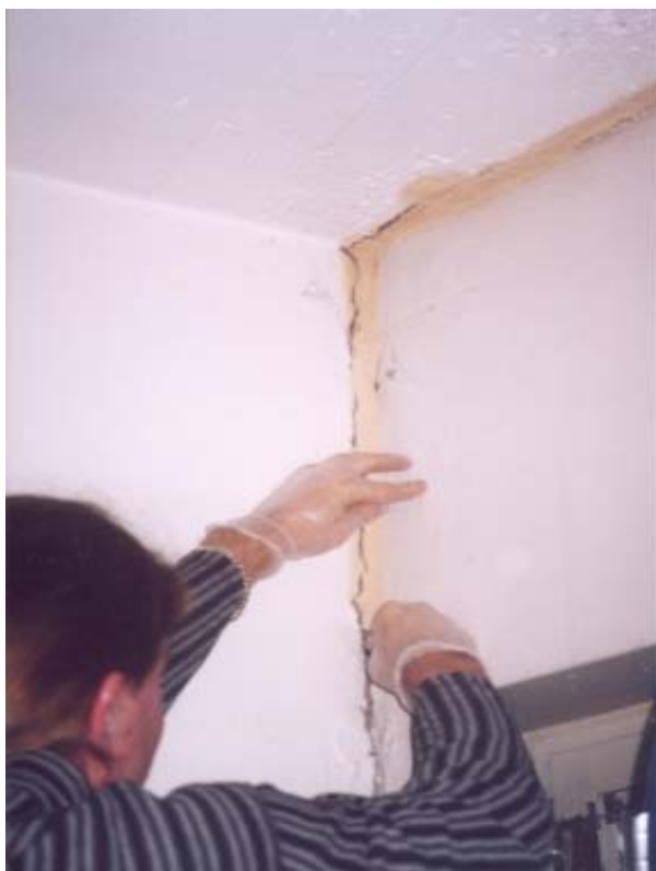
Abb.17 Entfernen einer Wandfuge
