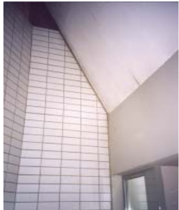
Abb. 14 Dehnungsfuge Decke
