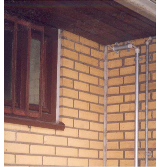
Abb. 15 Wand-Wand-Fuge im Außenbereich
